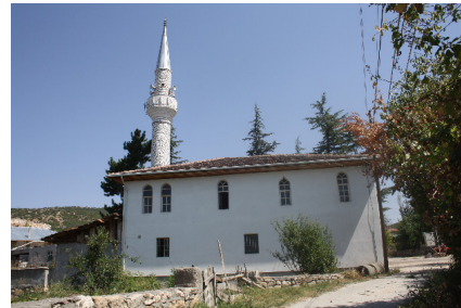
Fotoğraf 6: Batı cepheden görünüm
