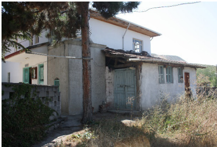
Fotoğraf 5: Kuzey cepheden görünüm
