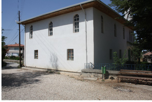
Fotoğraf 7: Güney cepheden görünüm
