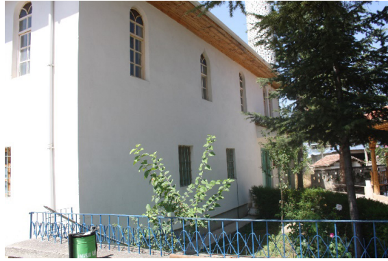
Fotoğraf 4: Doğu cepheden görünüm
